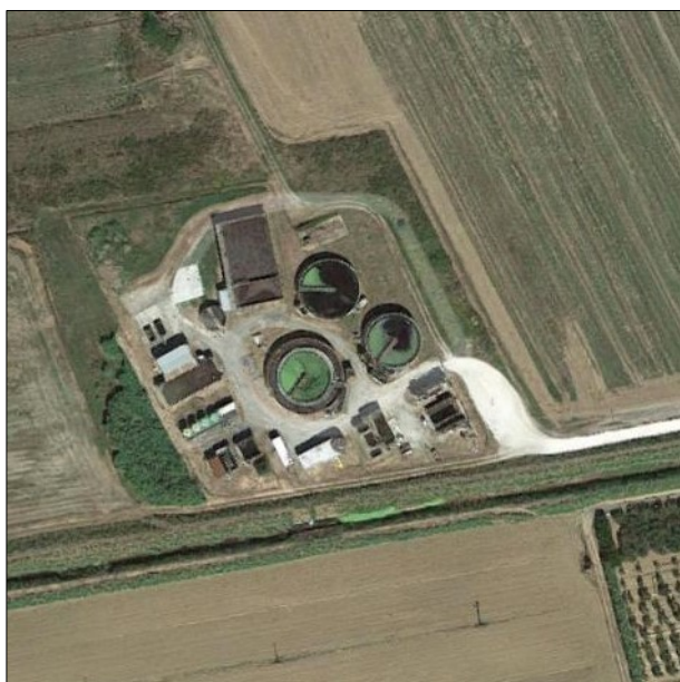
Depuratore di Bibbona
